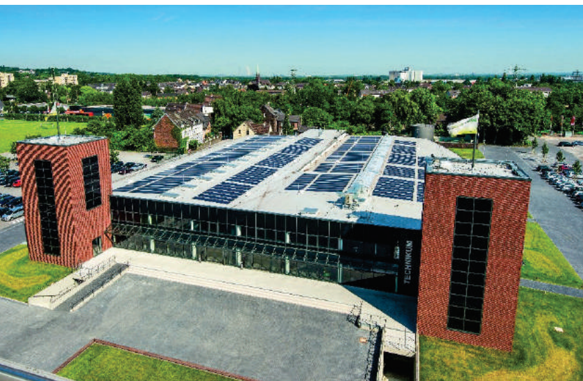
Technikum: Das Gebäude von Tengemann in Mülheim hat eine 2.232 qm große Fotovoltaikanlage auf Dach und Türmen, die jährlich ca. 70.000 kWh Strom gewinnen kann.
